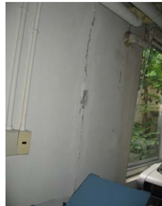
壁のひび割れ（柏崎市）
