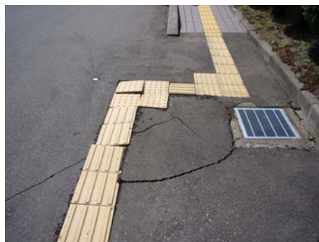
写真4 舗装のひび割れ（輪島市）
