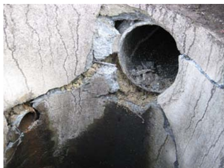
写真5 排水桝の破損（輪島市）
