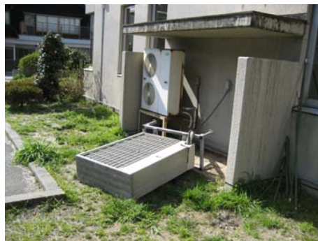
写真3 室外機の転倒（輪島市）
