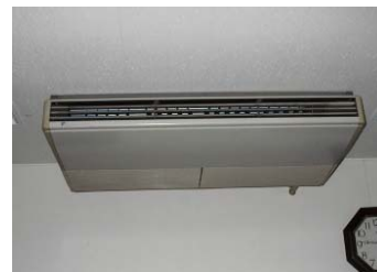
室内機:天井吊り露出形の例
