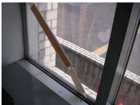
写真2 窓ガラスのひび割れ（富山市）
