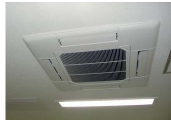
室内機:カセット形4方向吹出しの例
